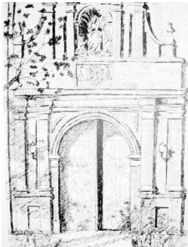
Fig. 3. Fachada de la Iglesia del Hospital de Ntra. Sra. de Gracia (P. Frías).
